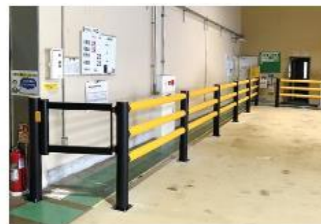
防護柵設置工事
