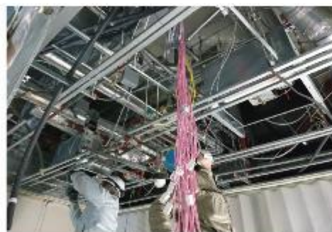
LAN配線工事
