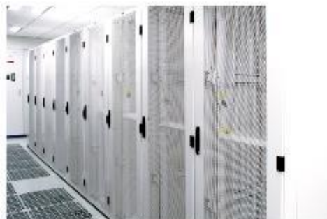
サーバーラック設置工事
