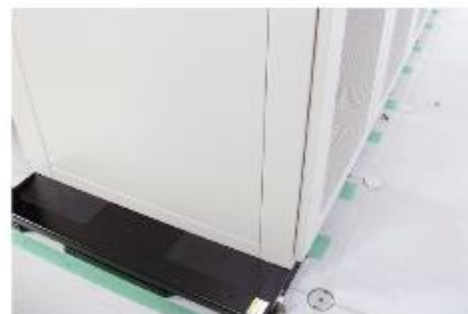
免震装置設置工事
