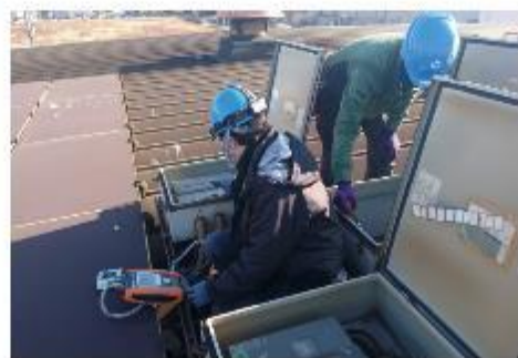
電気点検作業
