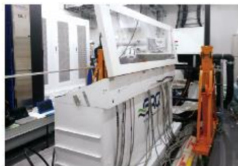
液浸冷却装置配線工事
