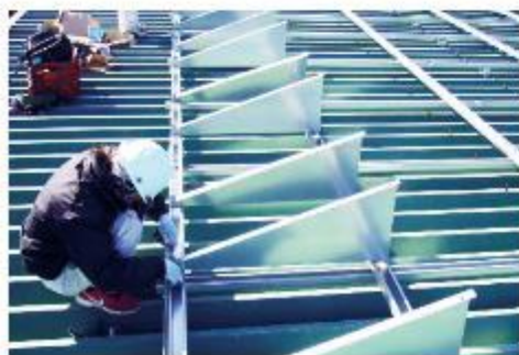
ソーラーパネル設置工事
