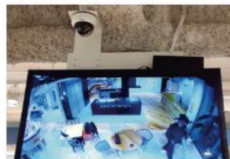
監視カメラ設置工事
