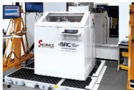
液浸冷却装置設置工事
