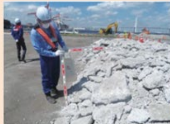
港湾工事で使用される鉱滓の再利用
